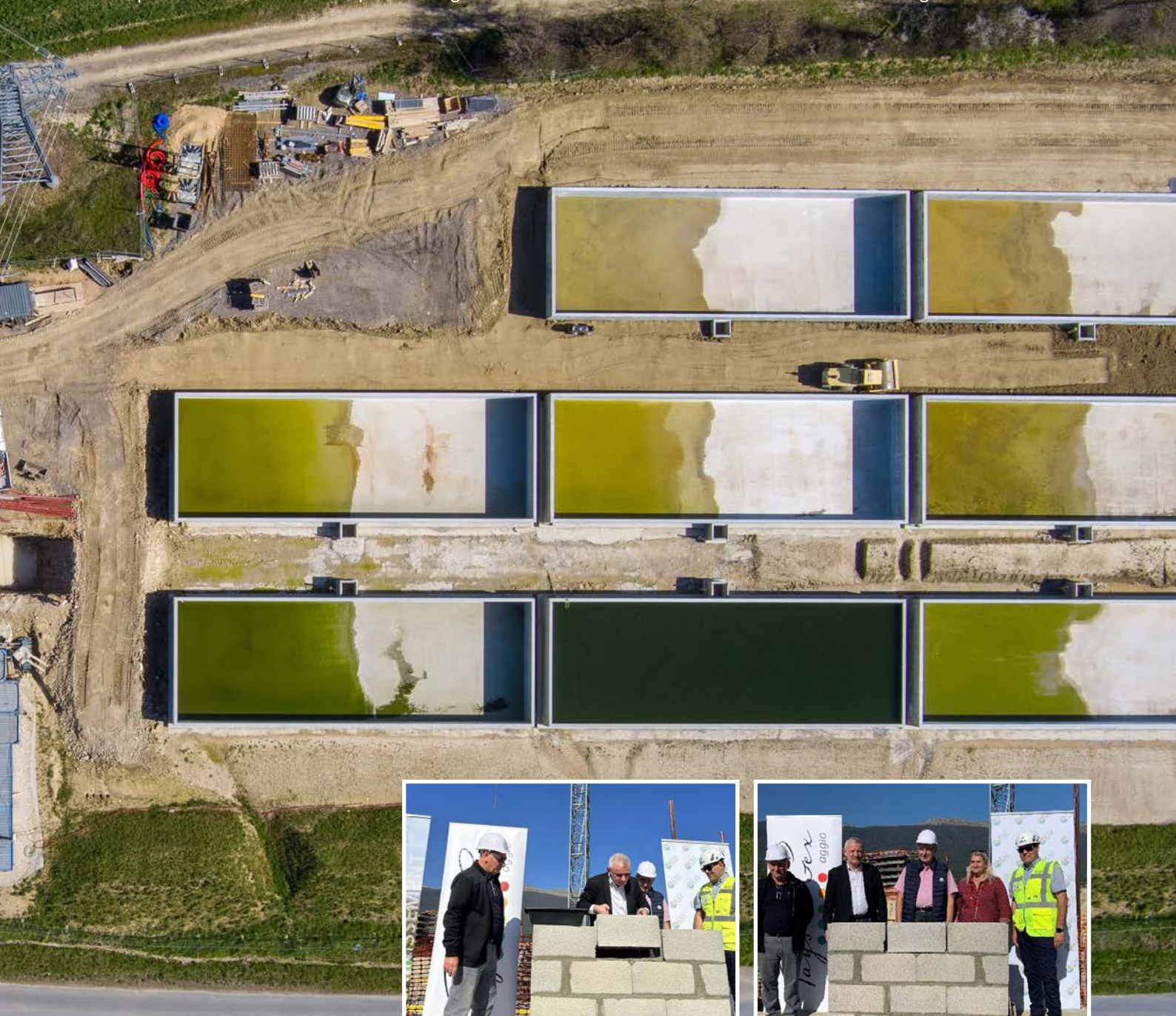
Pose de la première pierre
