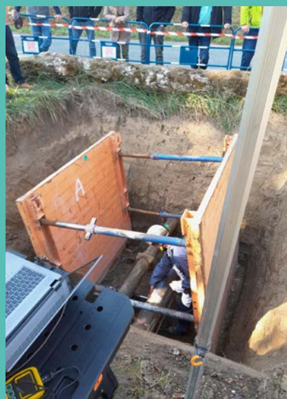
Présentation du scan 3 D de canalisations
