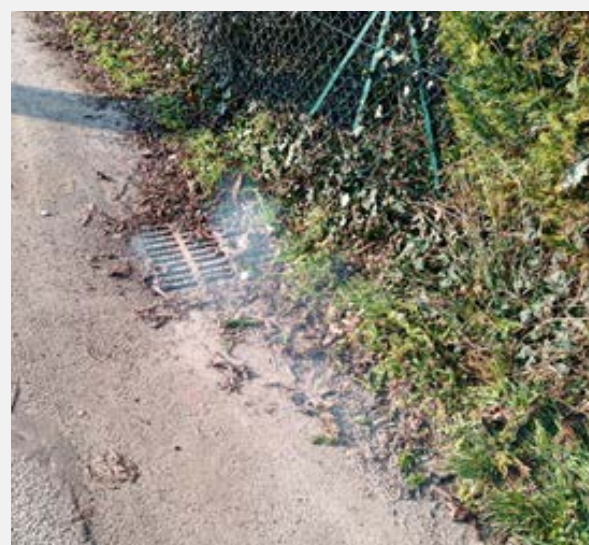
Essai à la fumée.
