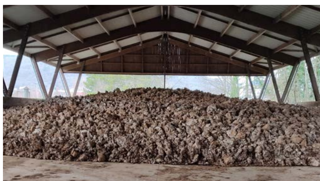
Hangar de stockage des boues de la station de Divonne les Bains avant épandage
